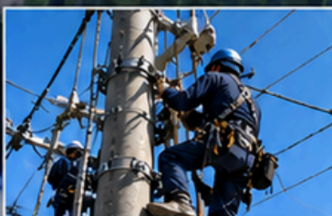
電柱工事 暮らしを支える
