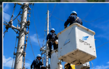
配電工事 街に電気を届ける
